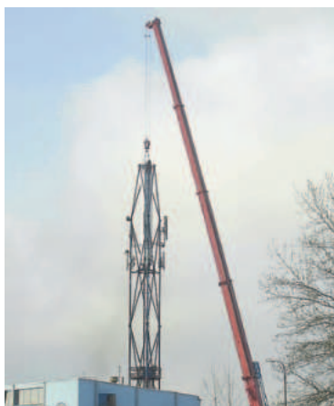
Wymiana kilkudziesięciometrowego komina to widowiskowe przedsięwzięcie
