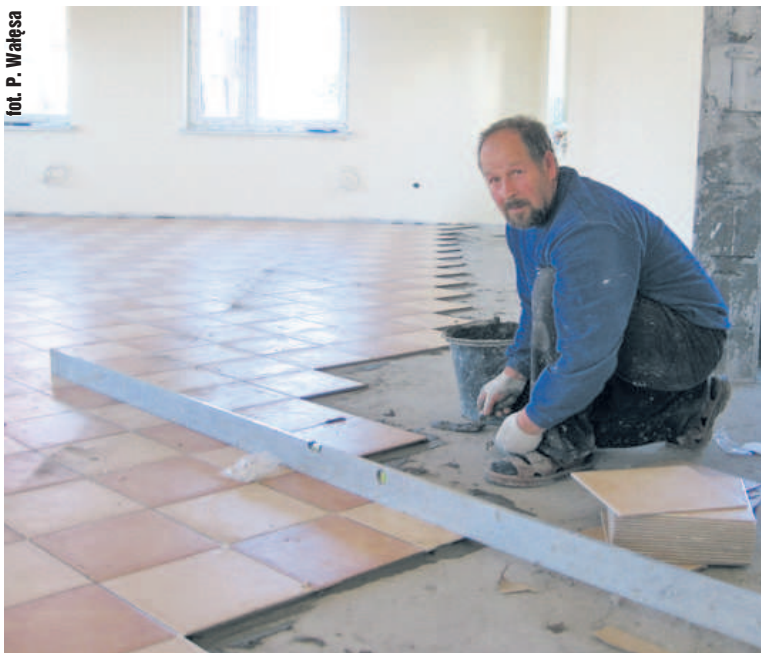
Eugeniusz Strulak kończy zakładanie płytek na podłogę w sali głównej centrum
