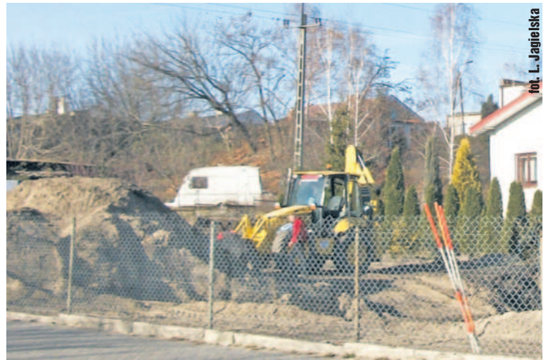
Prace przy budowie KRUS-u już się rozpoczęły
