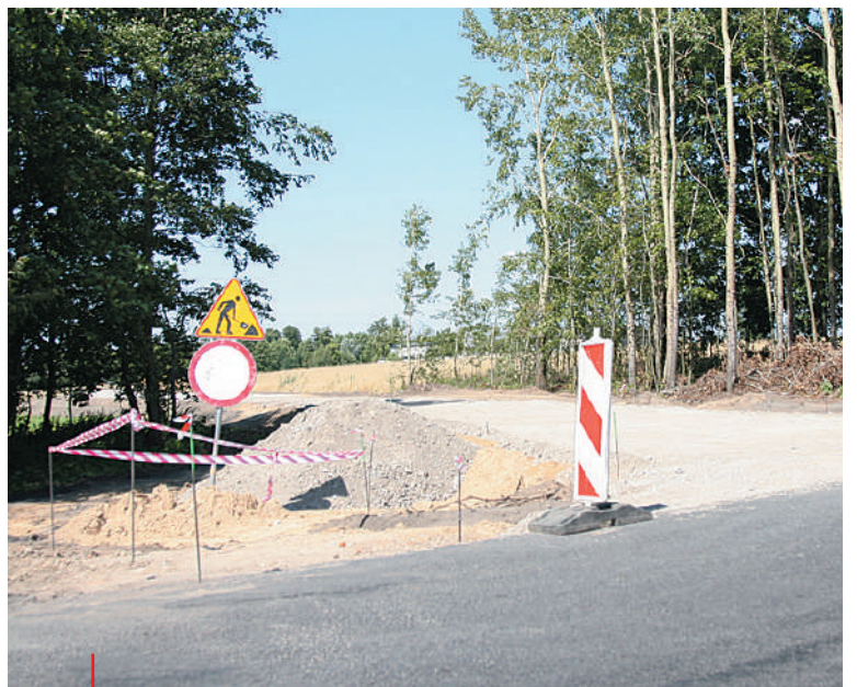
Prace trwają m.in. na drodze w Rumunkach Oleszeńskich, tu powstanie prawie 600 metrów jezdni
