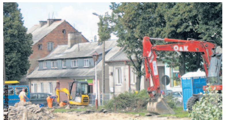
Prace na Placu Dekerta rozpoczęły się we wrześniu. Teraz trwa przerwa, wykonawca wróci wiosną
