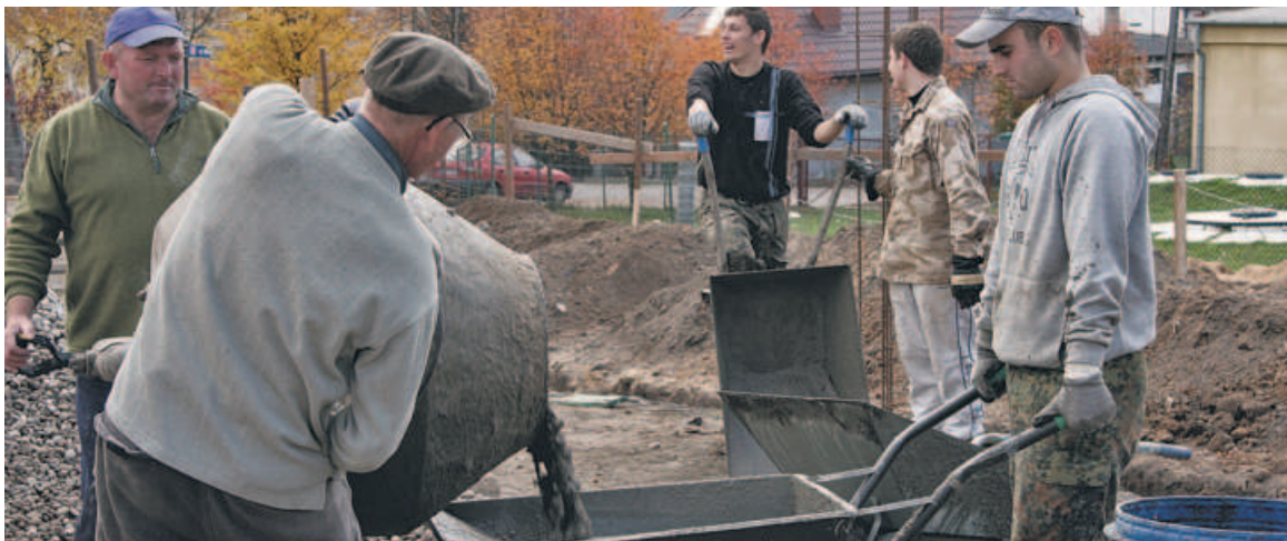
Strażacy nie szczędzą prywatnego czasu na budowę garażu
