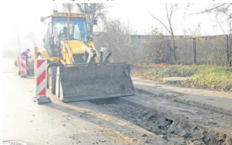
Prace ziemne na ul. Żeromskiego
