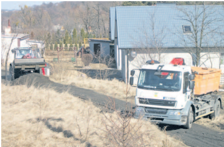
Prace na drogach trwają
