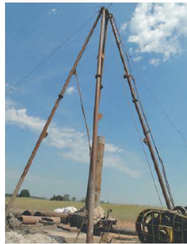
Nowe ujęcie wody w Wichowie może rozwiązać problemy mieszkańców.
