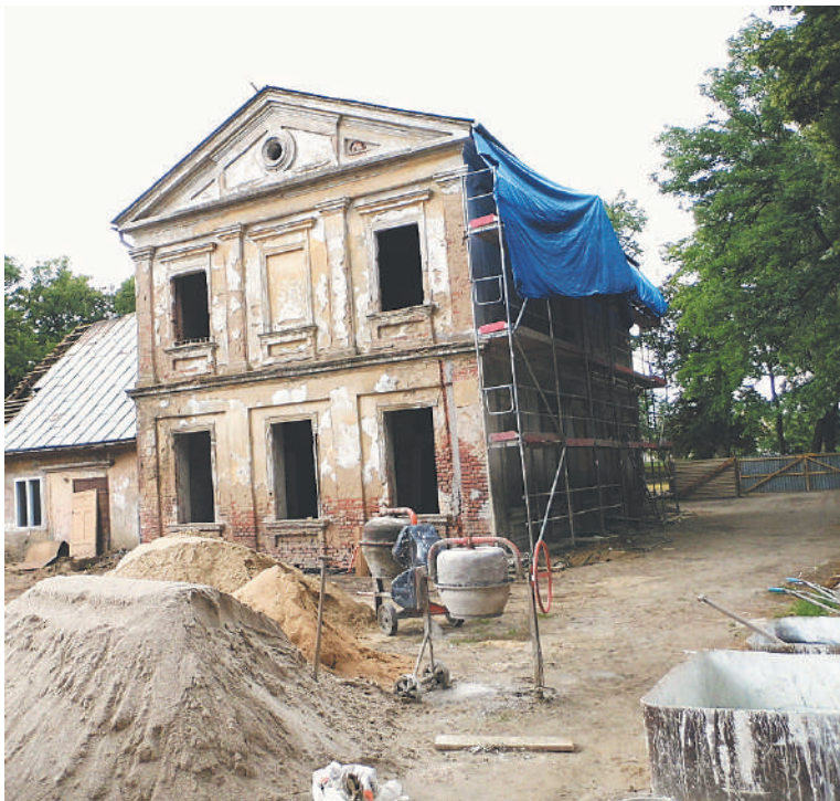
Prawie 1,7 mln zł na remont pałacu wyłoży budżet centralny. Całość ma być gotowa jeszcze w tym roku
