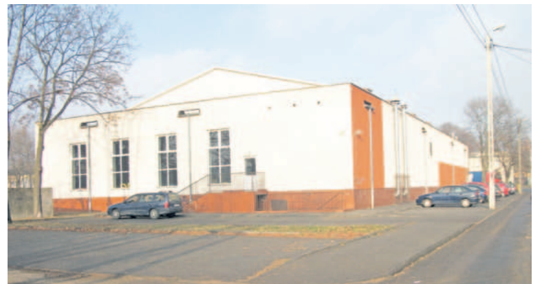
Miejski ciepłociąg zastąpi ogrzewanie olejowe na basenie
