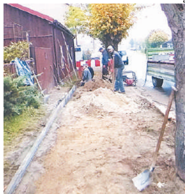
Ruszyła budowa chodnika przy ulicy Sierpeckiej
