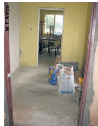
W trakcie remontu jest główna sala strażnicy
