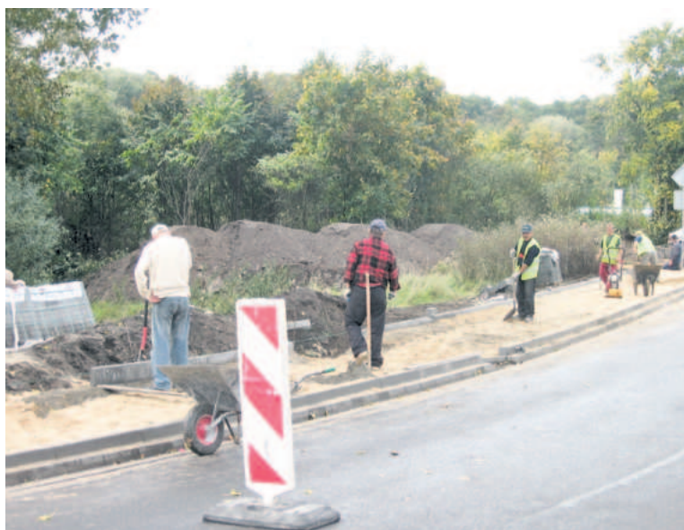
Do pracy przy układaniu chodnika zatrudnieni są bezrobotni w ramach robót publicznych
