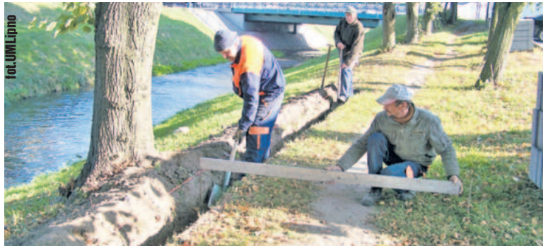
W tym miesiącu chodniki będą gotowe
