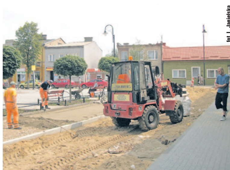
Na Placu Dekerta kładziona jest nawierzchnia
