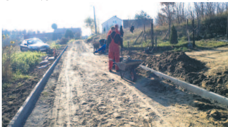
Pracownicy spółki PUK remontują odcinek pozostawiony po poprzednich robotach
