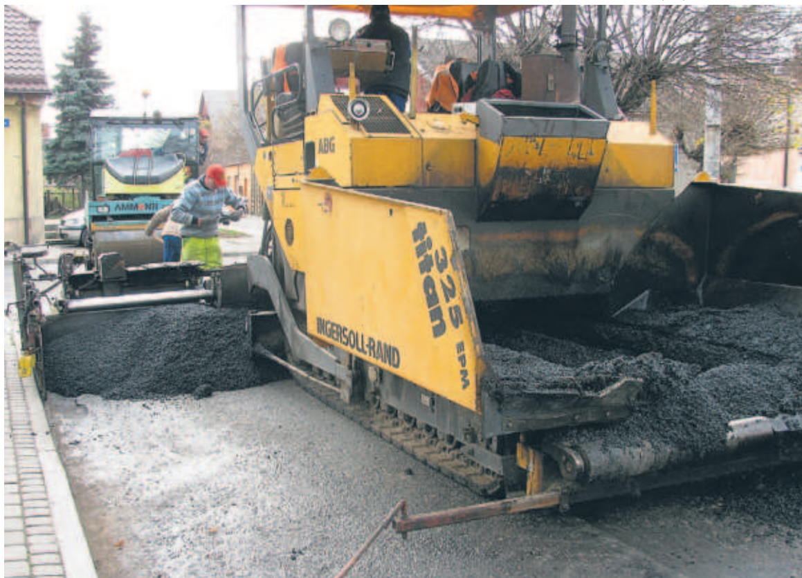
Wykonawcą robót na ulicach Dobrzynia nad Wisłą było Przedsiębiorstwo Robót Drogowych z Lipna
