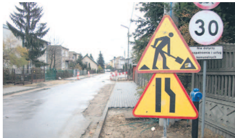
Na ulicy Ogrodowej układane są chodniki
