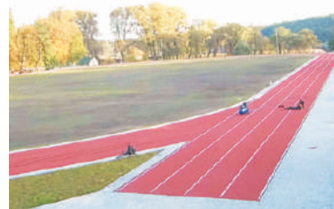
Trwają ostatnie prace na okazałym obiekcie
