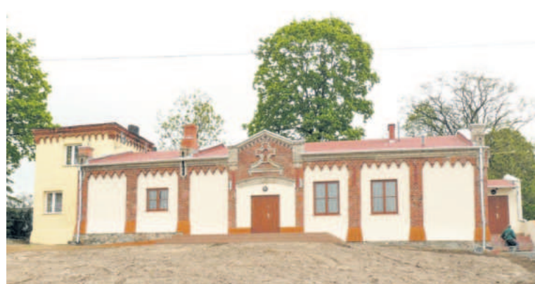
Nowo wyremontowana świetlica w Kikole
