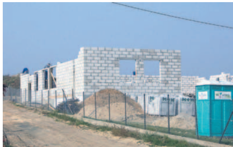
Na budowie świetlicy wiejskiej w Krzyżówkach praca w re.
