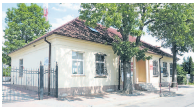
Budynek biura magazynu solnego w Bobrownikach, styl klasycystyczny, pierwsza poł. XIX w.
