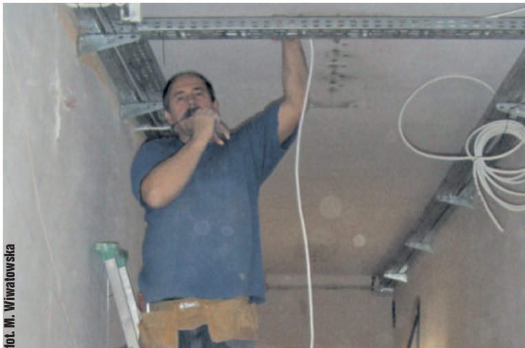
Pan Józef wymienia instalację elektryczną w siedzibie starostwa
