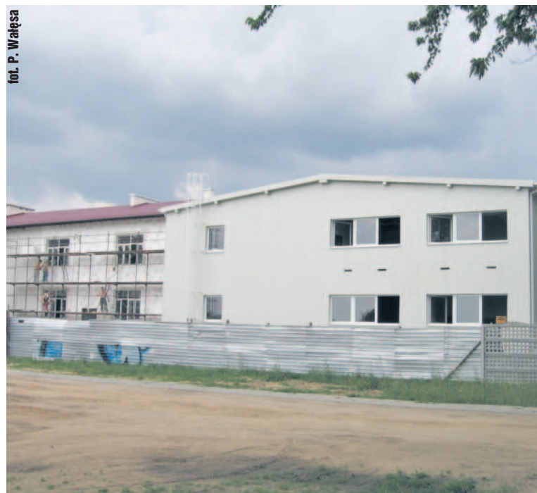
Prace przy budowie hali sportowej idą pełną parą. Możliwe, że jeszcze w tym roku korzystać z niej będą uczniowie podstawówki
