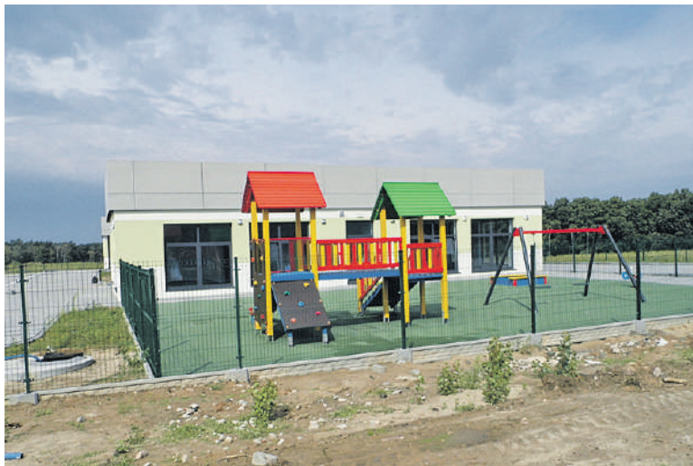
Na oddanie do użytku czeka też nowy obiekt powiatowy przy ulicy Nieszawskiej, gdzie powstanie żłobek i przedszkole
