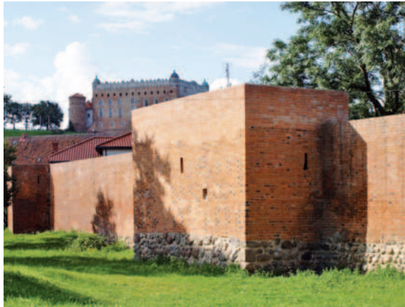
Warte uwagi są dobrze zachowane mury obronne
