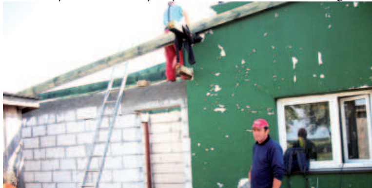
Obok remontowanej świetlicy w Kukowie stanął nowy budynek socjalny
