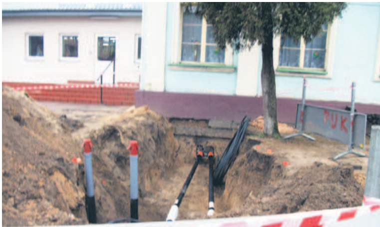
Trwa podłączanie ciepłociągu do SP nr 5
