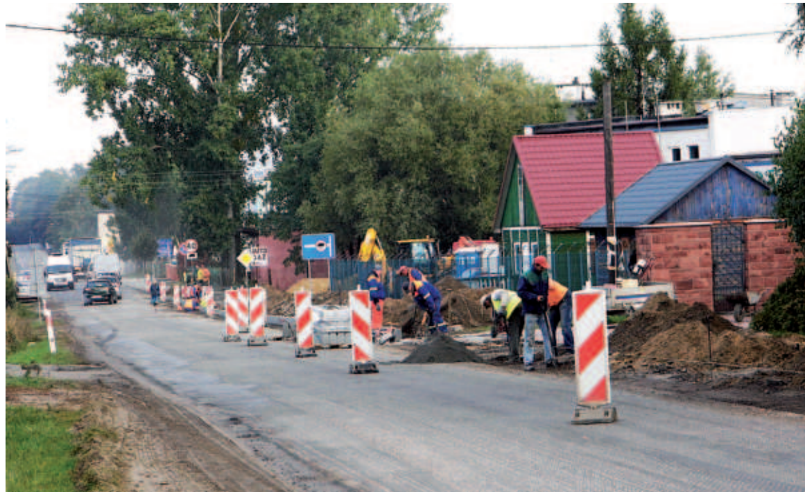
Trwa budowa nowej nawierzchni i chodników na kolejnych 265 metrach ulicy Okrzei
