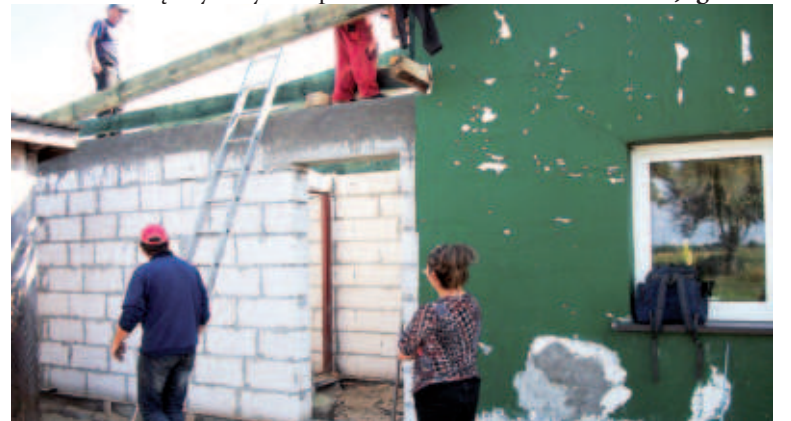
Prace na budowie trwają od trzech miesięcy
