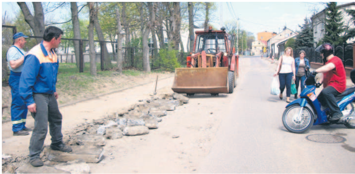
Pracownicy PRD w Lipnie już rozpoczęli roboty na ulicy Żeromskiego
