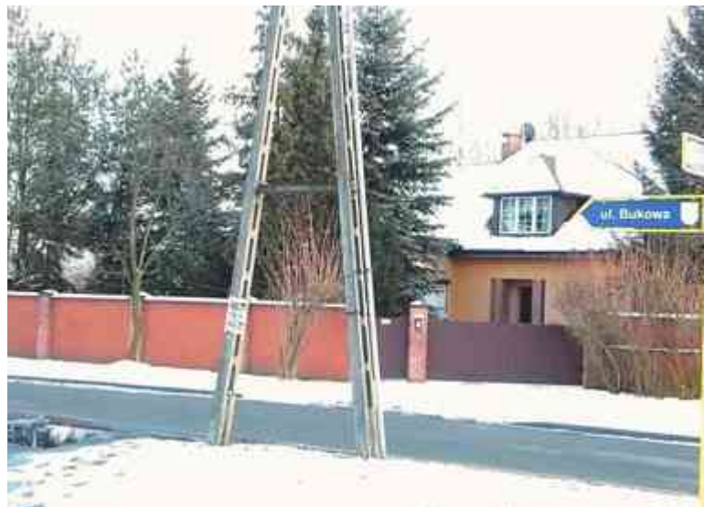
Wkrótce ruszy budowa pierwszego odcinka ulicy Bukowej
