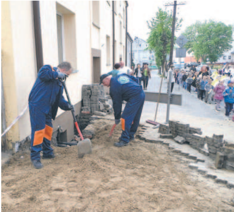
Obecnie trwa podłączanie kolejnych budynków do miejskiego ciepłociągu
