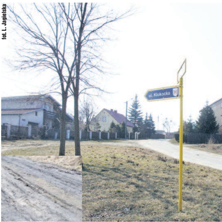
Ul. Kłokocka w Lipnie – na małym zdjęciu stan nawierzchni
