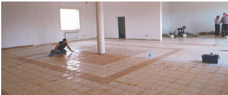
W świetlicy wiejskiej w Krzyżówkach pracownicy kładą ostatnie płytki
