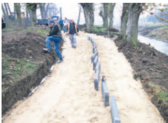
prace nad rzeką już trwają
