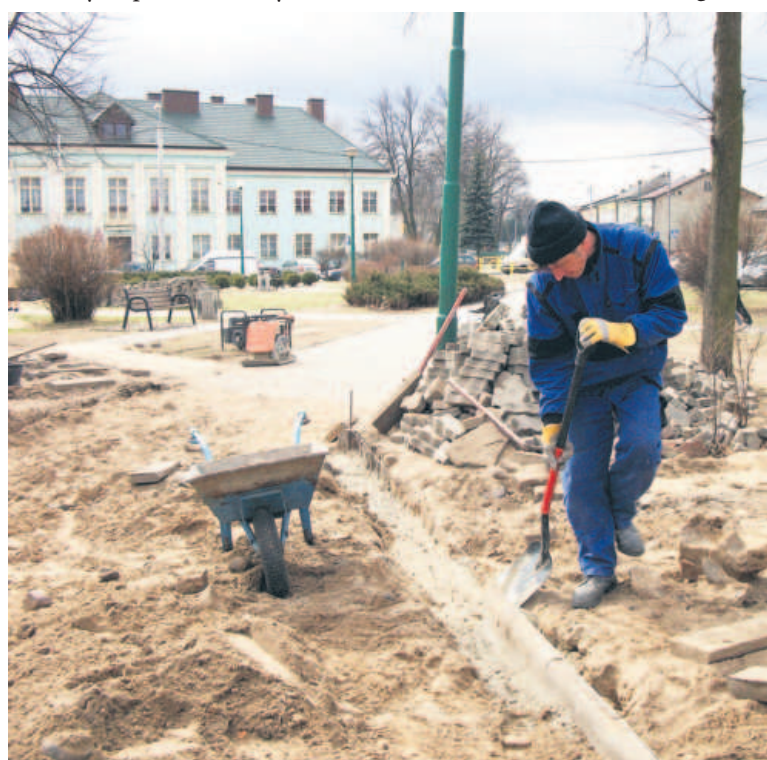
Prace na Placu 11 Listopada trwają
