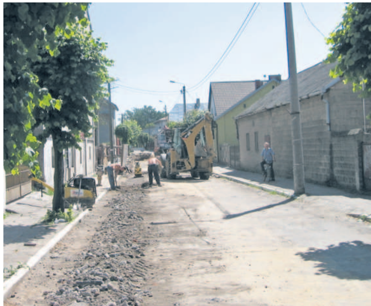
Ze względu na prowadzone prace nieprzejezdna jest ulica Słowackiego
