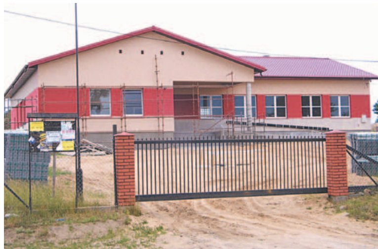
Prace na budowie świetlicy wiejskiej w Krzyżówkach dobiegają końca, a nowy obiekt nie przypomina w niczym starej strażnicy
