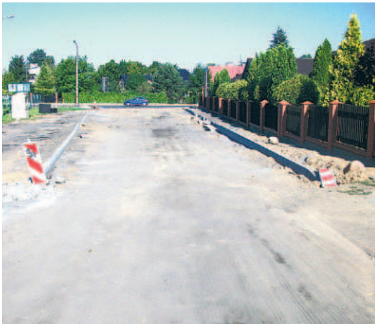
Tylko taki odcinek ulicy Ptasiej zyska nową nawierzchnię
