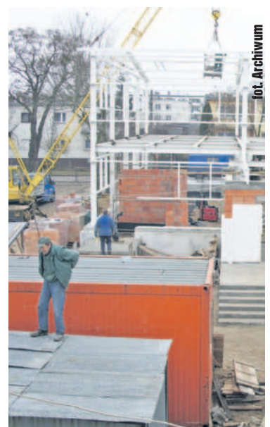
Budowa sali gimnastycznej to obecnie największa gminna inwestycja. Kosztuje tyle, co roczny dochód budżetu
