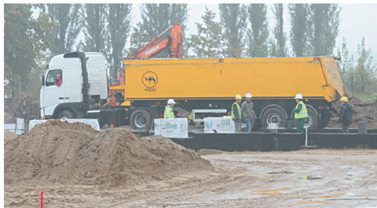
Na terenie należącym do zakładu trwają prace budowlane
