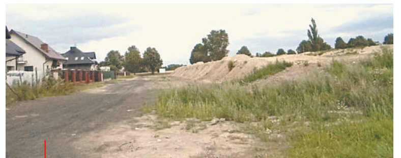
Rekultywację codziennie z okien oglądają mieszkańcy ulicy Mazowieckiej i zaniepokoił ich brak postępu prac
