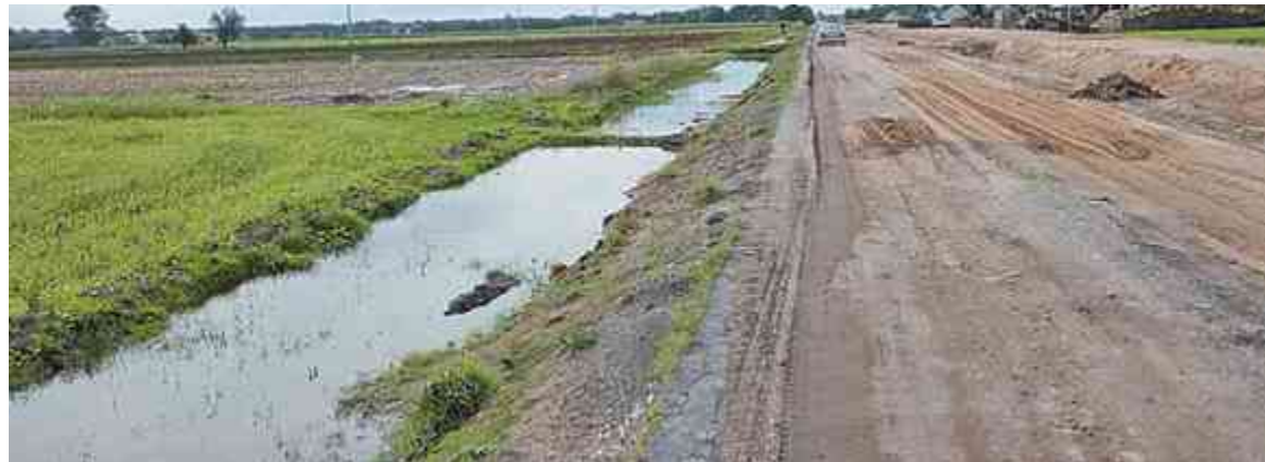
Tak obecnie wyglądają tereny przyległe do remontowanej drogi wojewódzkiej nr 559
