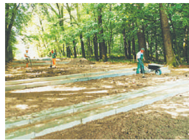
W przyszłym roku odnowione mają zostać kolejne schody prowadzące do parku – w okolicy Zespołu Szkół Technicznych
