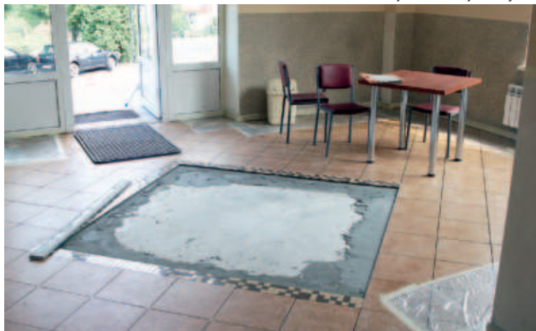
Przy wejściu do urzędu ułożono nowe płytki, a po środku dekoracyjną mozaikę
