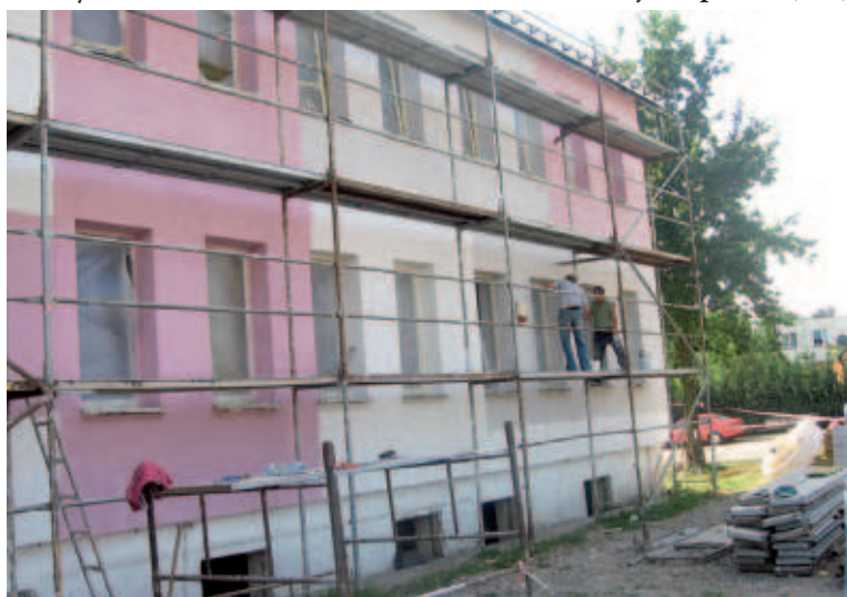
Odnawiana jest elewacja budynku
