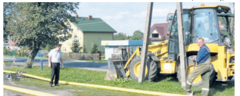
Październik: Tłuchowo pierwszą gminą w powiecie, mającą gaz. Rozpoczął się kolejny etap budowy gazociągu
