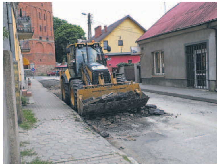
Prace przy ulicy Rapackiego rozpoczęły się w miniony wtorek
