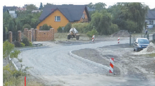
Droga jest już przygotowana do utwardzenia asfaltem
