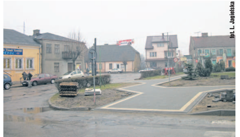
Wkrótce rozpocznie się ostatni etap kanalizacji Skępego
