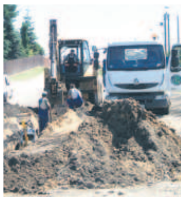
Przed budową drogi PUK wykonał kanalizację deszczową na ulicy Ptasiej
